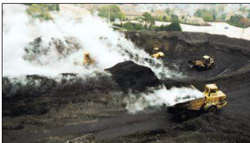
Figure 8 : Travaux dans les terrils en combustion au nord d'Alès (collection Y. Paquette, issu de [24])
