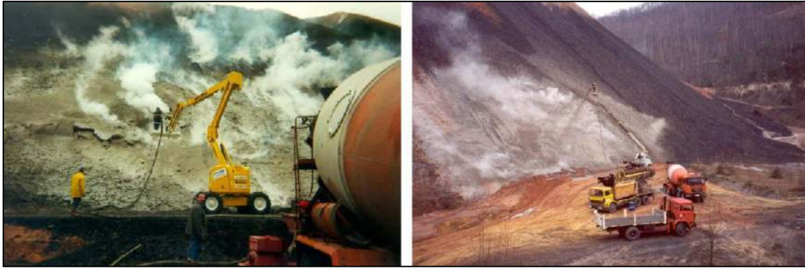
Figure 24 : Projection de béton pour étancher rapidement les secteurs en échauffement au niveau du terril Simon en 2000 (collection Y. Paquette, issu de [22])
