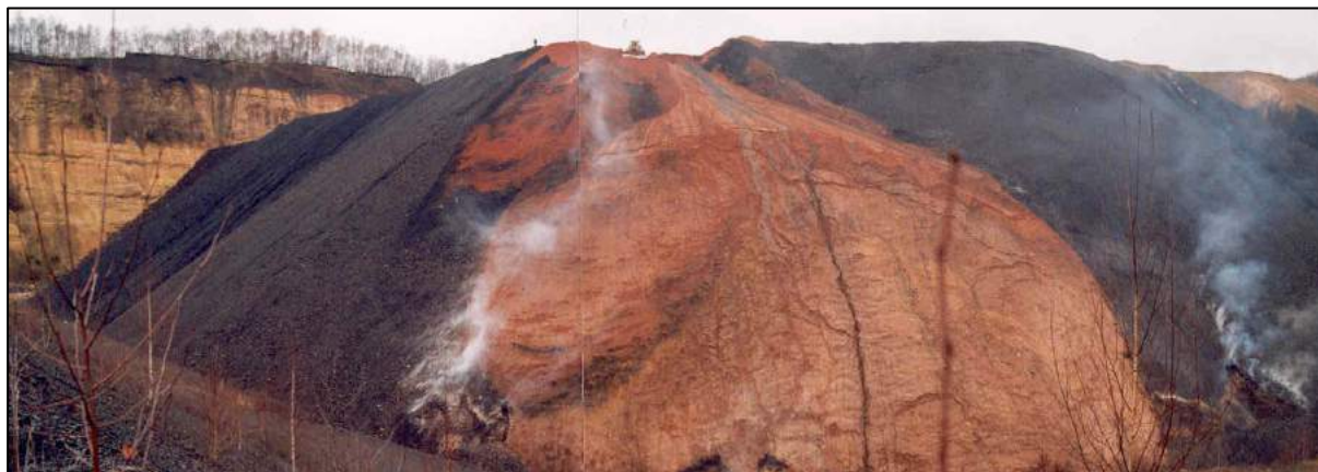
Figure 27: Schistier Simon, zone centrale, 3 décembre 1999, fumeroles en pied de talus, de part et d'autres de la coulée de sablons, poussés depuis le haut pour confiner l'échauffement (collection Y. Paquette, issu de [22])
